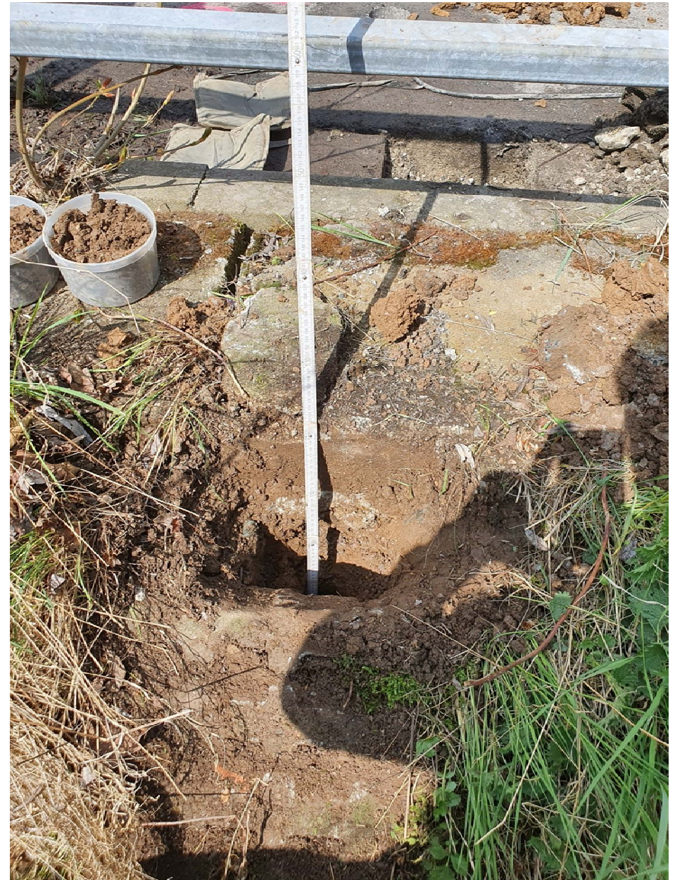
Bild 6: K 8768 Sürßen, Bachgeländer, Schurf S 13b bachseitig
