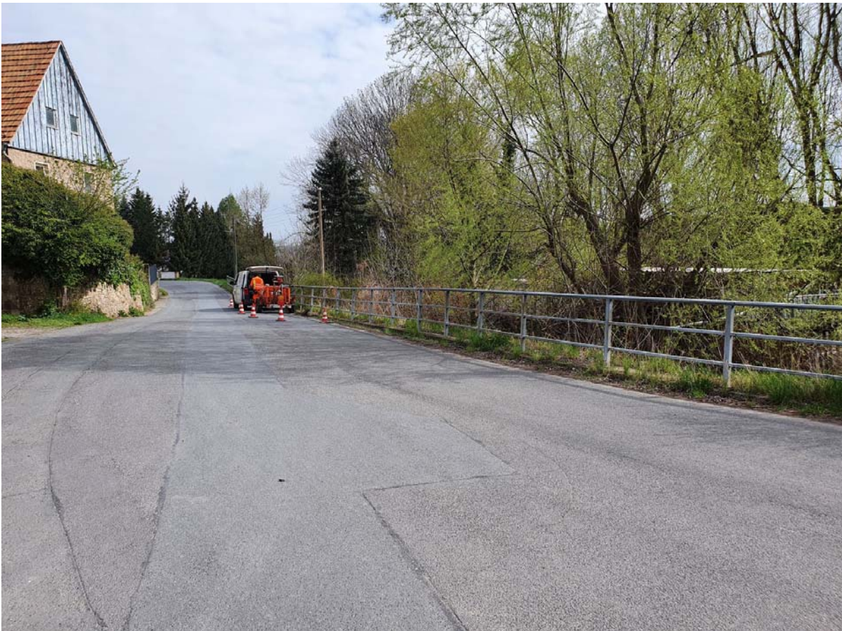
Bild 2: K 8768 Sürßen, Ansicht Bachgeländer aus Richtung Südwesten
